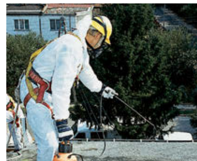
Do usuwania azbestu zatrudnia się przygotowaną do tego firmę. Azbest jest niebezpieczny wtedy, gdy pyli. Dlatego na czas prac jest on zwilżany i neutralizowany preparatem sklejającym jego włókna
