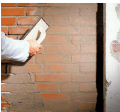
Spoiny na elewacji klinkierowej można odnawiać, stosując szlam do renowacji. Po usunięciu uszkodzonych fragmentów i uzupełnieniu głębokich ubytków szlam nakłada się na całą powierzchnię gumowaną pacą i wciska w spoiny, a nadmiar materiału usuwa
