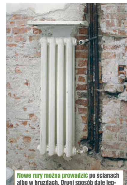
Grzejniki powinny być wyposażone w głowice termostatyczne, którymi reguluje się ilość ciepła w pomieszczeniu
