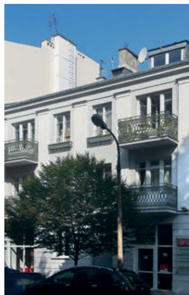
Minimalna wysokość balustrady w budynkach wielorodzinnych to 1,1 m. Jest mierzona od powierzchni balkonu do wierzchu balustrady
