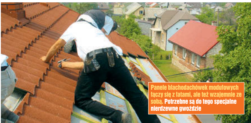
Blaszone panele z fabrycznie wyprofilowanymi rąbkami to jedyny rodzaj blachy płaskiej, który mocuje się nie do sztywnego poszycia, tylko do konstrukcji z kontrłat i łąt
