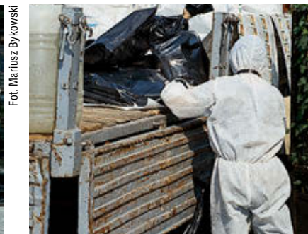
Usunięte płyty umieszcza się w workach, a te wkłada do polietylenowych opakowań. Worki pakuje się na samochód, okrywa plandeką i wywozi na specjalne składowisko, które przyjmuje odpady zawierające azbest
