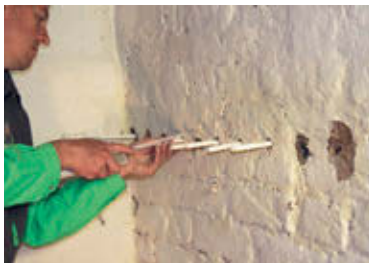
Po przedmuchaniu otworów sprężonym powietrzem mocuje się w nich wałki dozujące o długości równej szerokości muru + 7 cm
