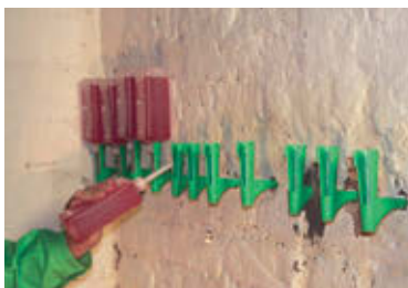
W uchwytach mocuje się kartusze z płynem iniekcyjnym, który powoli wsiąka w mur
