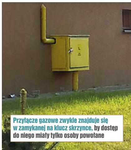
Wewnątrz budynku instalacja powinna być prowadzona prostymi odcinkami, a jeśli nie jest to możliwe, jej załamania powinny być łagodne. Rury gazowe zawsze maluje się na żółto
