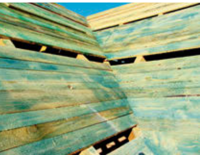
Szttywne poszycie wykonuje się standardowo pod pokrycia płaskie. Można do tego użyć zwykłych impregnowanych desek lub płyt drewnopochodnych (OSB, MFP, sklejki wodoodpornej)
