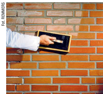
Po 30-60 minutach od szlamowania, gdy nie oddzieli się już zaczyn cementowy, elewację trzeba wyczyścić gąbką z niewielką ilością wody
