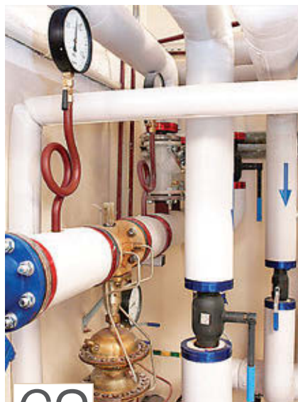
62 Jak zmodernizować instalację ciepłej wody użytkowej? Pokazujemy krok po kroku
