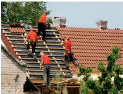
Konstrukcję z drewnianych łąt i kontrłat stosuje się pod pokrycia profilowane. Kontrłaty nabija się wzdłuż krokwi, a łaty prostopadle do nich
