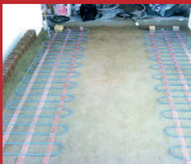
Kable grzejne można ułożyć na przykład tylko pod tą częścią ścieżki, która jest położona najbliżej wejścia do klatki
